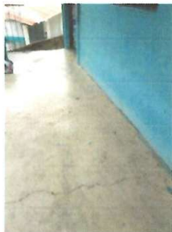
FOTO No.1 PISO. Sustrucción de piso de concreto alisado por piso cerámico.
