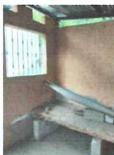
FOTO No. 5. AREA DE COCINA. Sustrucción de estufa rural en plancha y chimenea.
