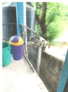
FOTO No. 4. BARANDAS. Sustrucción de barandas en mal estado y corroídas por barandas nuevas.
