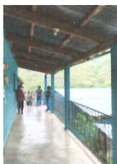
FOTO No. 2. ESTRUCTURA DE TECHO. Sustrucción de estructura de techo de madera por estructura de metal.
